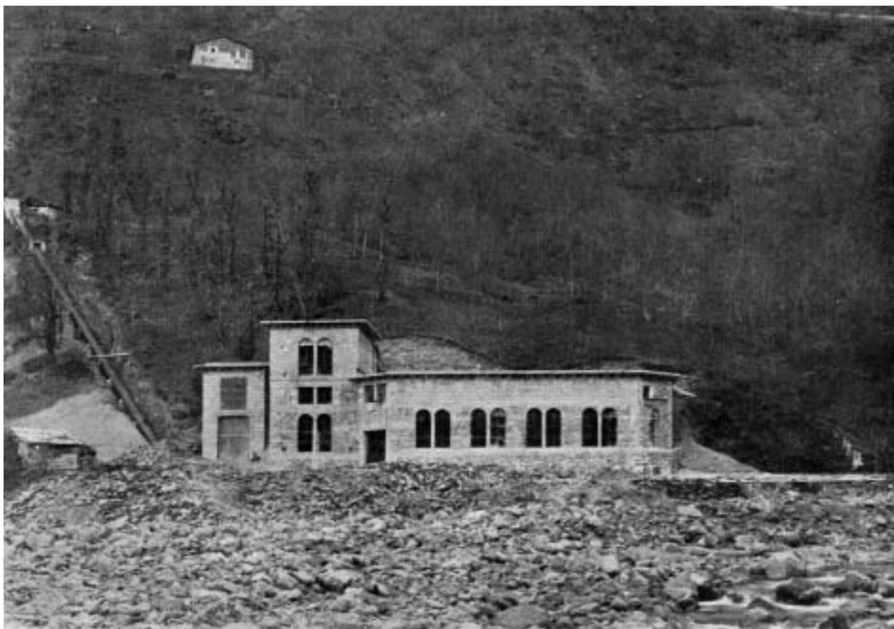
La Centrale riscattata di Enfrators, nel corso dei lavori di allestimento (1932).
