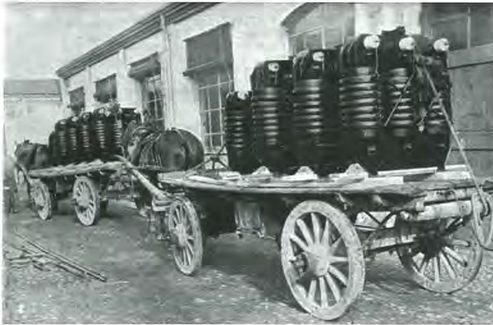
Trasporto a cavallo di trasformatori elettrici.
