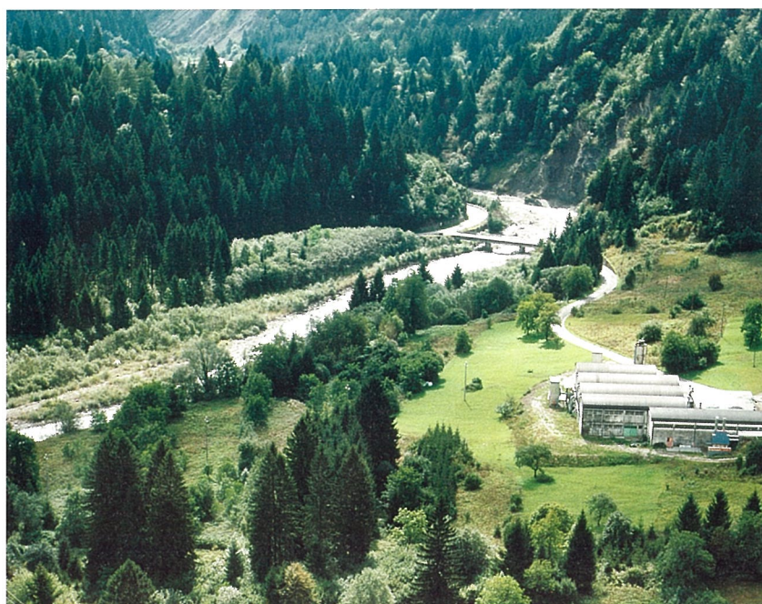
Il sito del nuovo impianto La valle del But a Noiariis (in basso) e il sito della nuova centrale prima dell'inizio dei lavori
