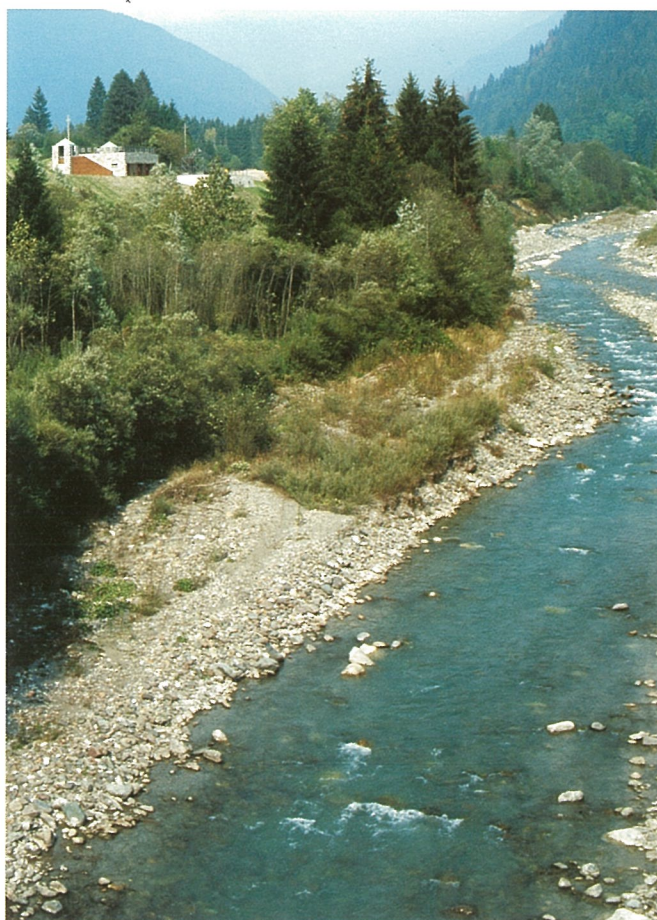
Il torrente But e la centrale idroelettrica a Noiaris – Sutrio
