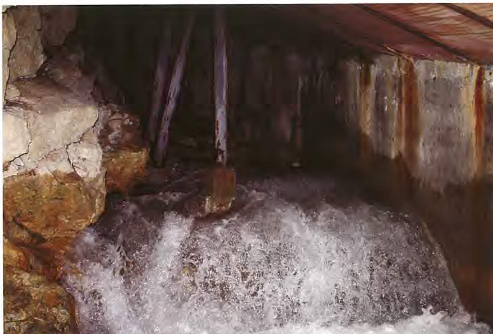
Fig. 2 - Interno della captazione del Fontanone di Timau (foto E. Zavagno).
