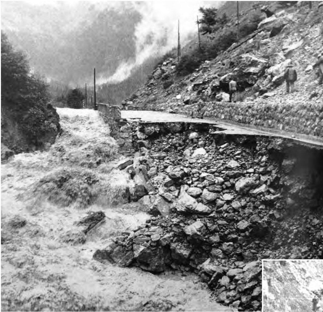
Fig. 154 – Appena a valle dei Laghetti, l'acqua acquista velocità (e capacità erosiva) scendendo lungo il ripido margine orientale della frana del Masareit. Gli effetti che si produssero durante l'alluvione del 1958 sono ancora vivi nella memoria di chi osservò in diretta il precipitare degli eventi. (Da Amodeo et al., 1968, in 'Il traforo di Monte Croce Carnico').
