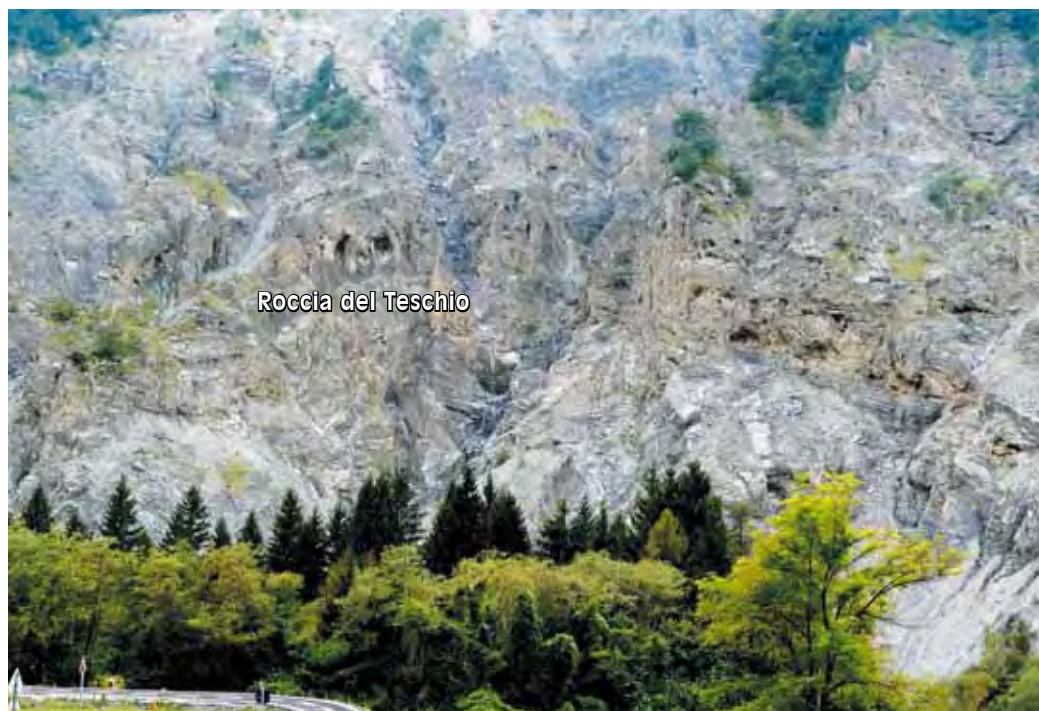
Fig. 85 – La parete rocciosa chiamata Araseit, sottoposta a incessanti erosioni. La ragione della sua instabilità è da cercarsi nel particolare tipo di roccia (in buona parte dolomie brecciate della Formazione a Bellerophon), ma soprattutto nella erosione al piede del versante prodotta dal Torrente Bût, spinto verso l'esterno dagli afflussi detritici del Rio Randice che, proprio sotto la parete rocciosa, vi confluisce.
