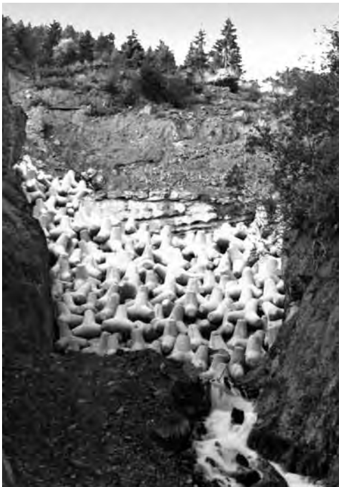
Fig. 178 – Il Rio Moscardo, nel suo tratto mediano, incide il substrato roccioso (Flysch ercinico, il libro scuro). Si notano i resti di due differenti tipi di intervento che, a distanza di molti decenni uno dall'altro, avevano tentato di rallentare le erosioni. Entrambe le soluzioni sono fallite, con le opere di contenimento che sono state divelte o scalzate dalla furia delle acque e delle colate detritiche. La foto risale al 1978.
