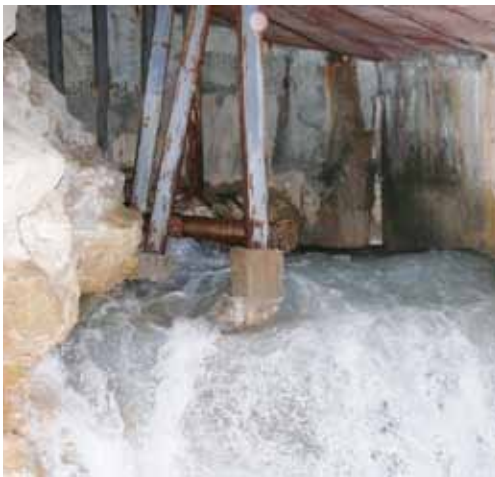
Fig. 14 – Immagine dell'interno dell'opera di presa del Fontanone.
