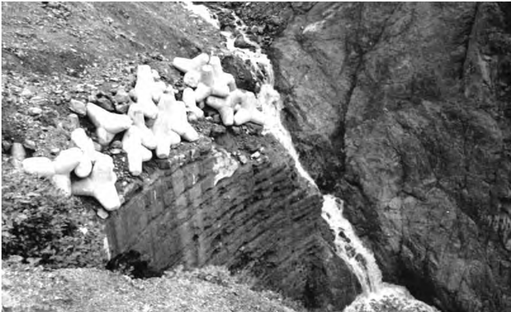
Fig. 178 – Il Rio Moscardo, nel suo tratto mediano, incide il substrato roccioso (Flysch ercinico, il libro scuro). Si notano i resti di due differenti tipi di intervento che, a distanza di molti decenni uno dall'altro, avevano tentato di rallentare le erosioni. Entrambe le soluzioni sono fallite, con le opere di contenimento che sono state divelte o scalzate dalla furia delle acque e delle colate detritiche. La foto risale al 1978.
