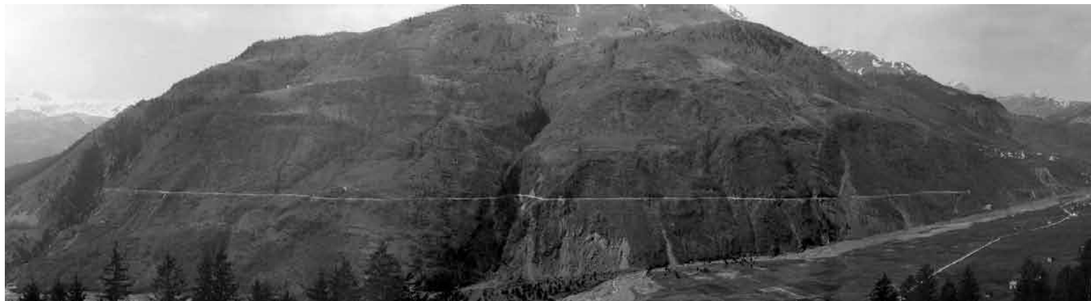
Fig. 7 – La condotta di adduzione della centrale di Enfretors lungo le pendici del Monte Tenchia.
