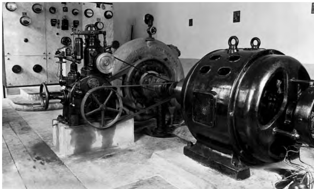
Fig. 4 – Fontanone - Sala macchine (1913).
