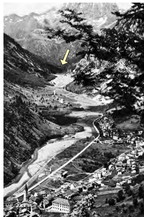
Fig. 148 – In una cartolina fine anni '20, la frana del Masareit si staglia sullo sfondo, lungo il versante idrografico destro (freccia). (Archivio Mauro Unfer, coll. Cimentì).
